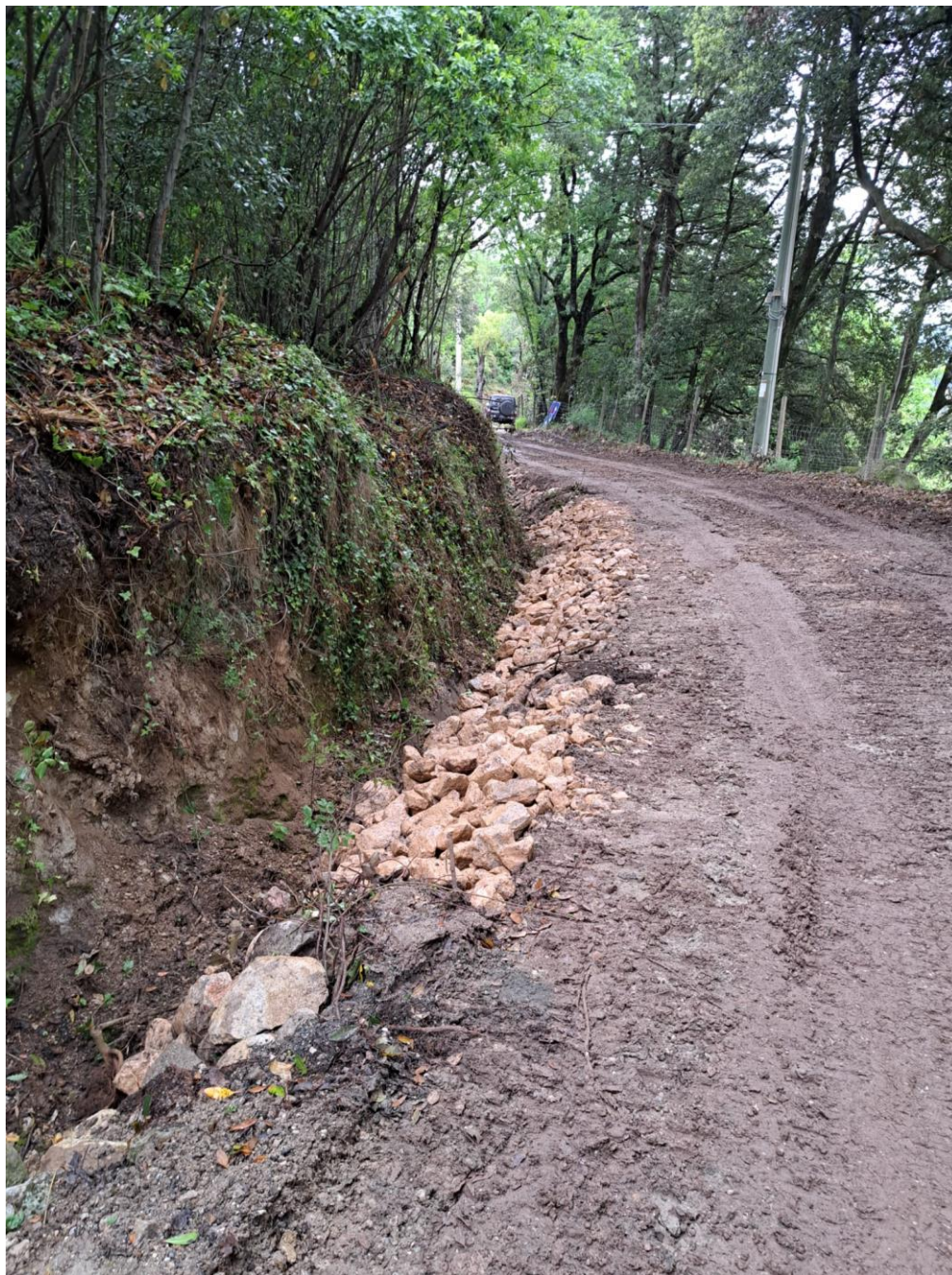
Foto 2 – Lavori in esecuzione
