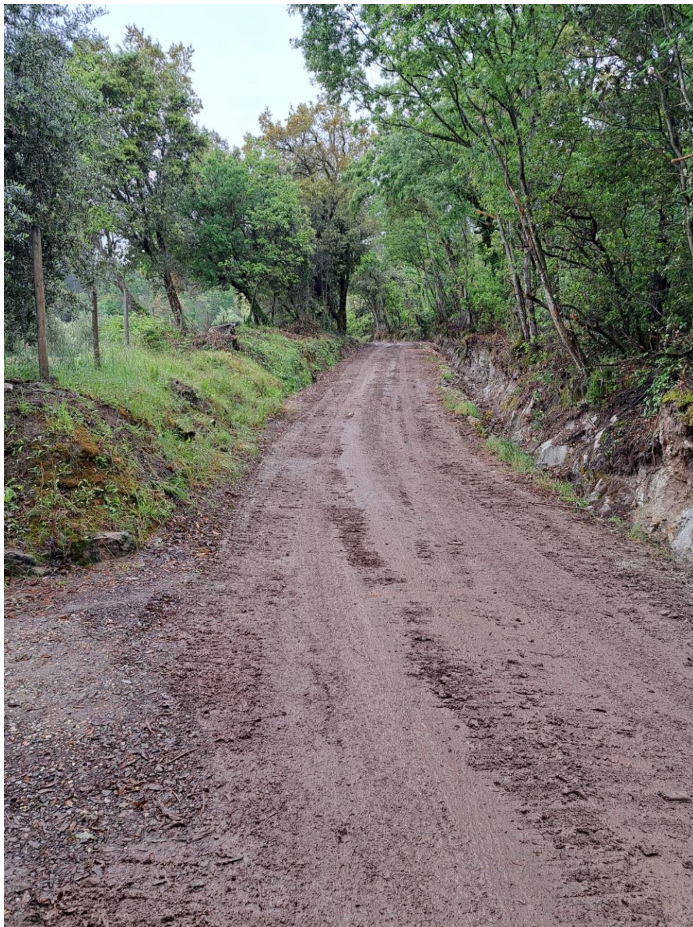
Foto 1 – Lavori in esecuzione
